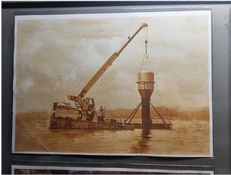
Die Versenkung des Ansaugkorbes Rohwasser – Pumpwerk Sonnefeld, Stäfa ZH 1990.
