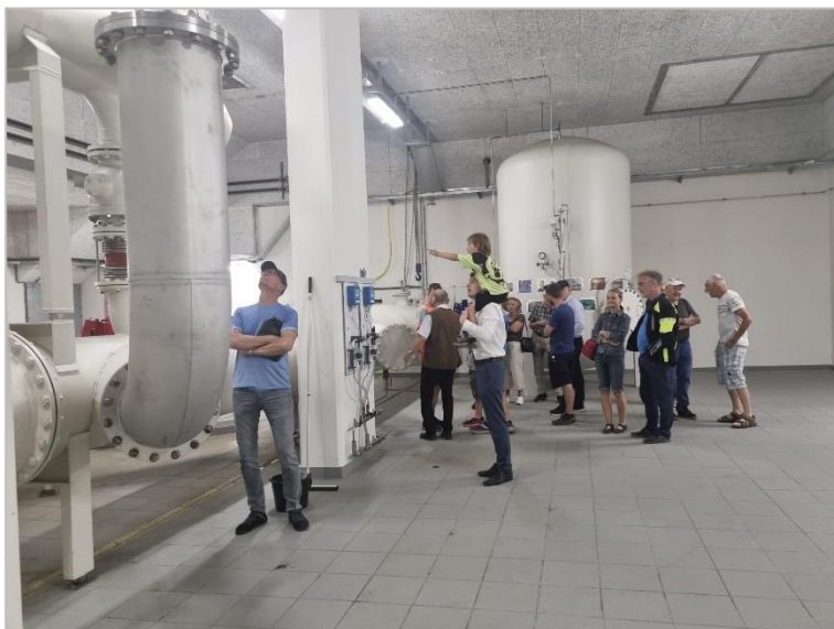
Im Untergeschoss werden die gross dimensionierten Rohrleitungen und die drei grossen Rohwasserpumpen bestaunt ....
