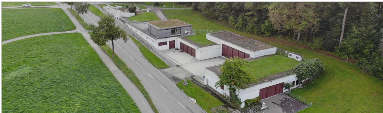
Wasseraufbereitungsanlage Mühlehölzli ob Stäfa ZH (696'974 / 234'863)
