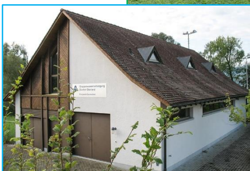
Pumpwerk Sonnenfeld Stäfa
